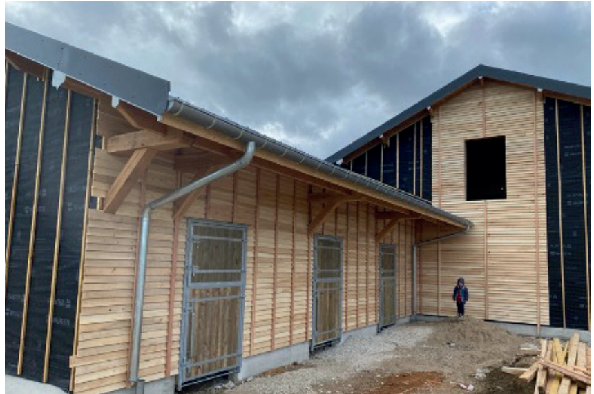
Die Pferdeställe der Champs Liberts im Bau, April 2024 in Urville. Sie werden sechs Pferde und alles notwendige Material aufnehmen.
